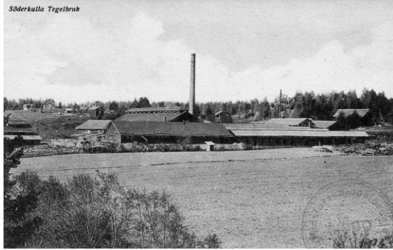
Söderkulla Gård & Verkstäder rakensi suuren ja uudenaikaisen tiilitehtaan. Tehdas pystyi vuoden aikana tuottamaan 2 miljoonaa seinätiiltä, 100 000 kuivatusputkea ja 150 000 kattotiiltä (SHF).
