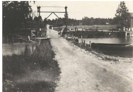
Sipoonjoen ylittävä silta Söderkullassa (SHF)
